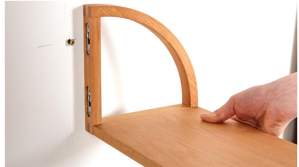
**2. Zusammengestecktes Regal an der gewünschten Stelle waagrecht an die Wand halten (Wasserwaage!) – hier dargestellt in der Variante „Bügel oben“.** Bohrstellen an der Wand markieren (jeweils nur für die obere Wandhalterung der Bügel), bohren, dübeln, Schrauben eindrehen.
